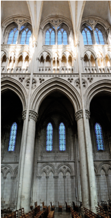
Devant chaque pilier de la nef monte une colonnette jusqu'à la retombée de la voûte en coupant le chapiteau et passant devant les roses sculptées en creux.
