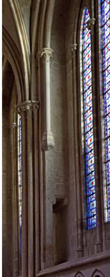
Devant les baies de la nef, un jeu de colonnettes suspendues.
